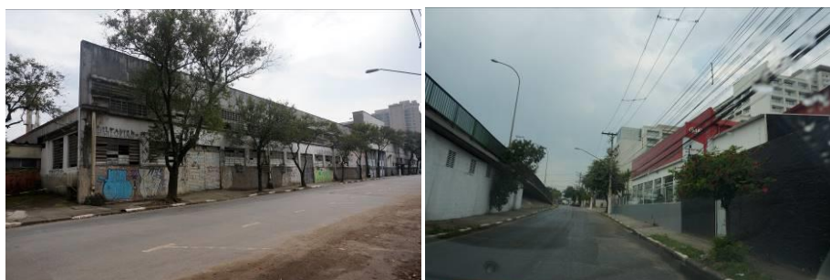
Figuras 1 e 2: Imedições da Av. Mofarrej Vila Leopoldina: Imóveis vazios a espera de comercialização.
