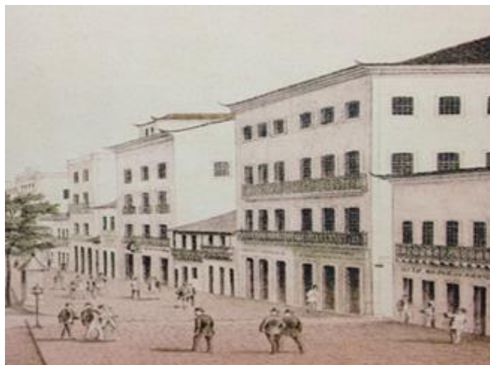
Figura 01. Casas térreas e sobrados no Recife.
