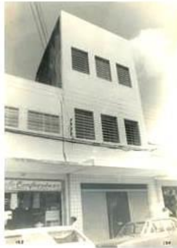
Figura 11. Edifício que perdeu os elementos / adornos caracterizadores do edifício histórico no bairro de São José, fotografado na década de 1970 para o levantamento que subsidiou a instituição dos Sítios Históricos no Recife (Decreto no 13.957 / 1979).
