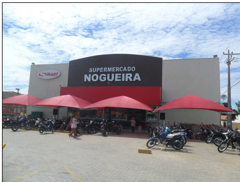
Foto 1: Juazeiro do Norte. Fachada do Supermercado Nogueira, no bairro Tiradentes, 2012
