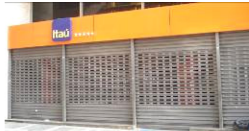
Figura 17: Exemplo de edificação com 'porta de enrolar' em ferro. Fonte: Ferraz, 2008.
