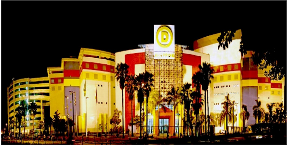
Foto 2: Fachada do Shopping D (São Paulo/SP)
