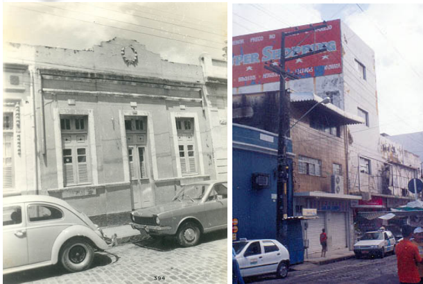
Figuras 7 e 8. Edifício descaracterizado. Rua das Calçadas 394, década 1970 e ano 2005.
