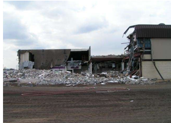
Demolição do Apache Mall em 2004. Fonte: www.apacheplaza.com/demolition .
