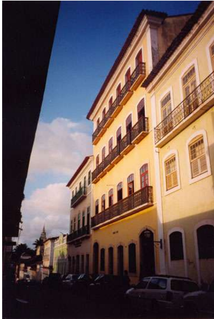
Figura 6 – São Luis (MA). Área do centro histórico que foi recuperada.
