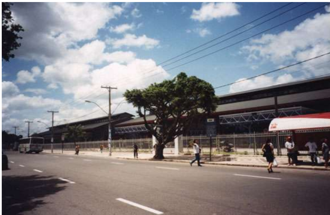
Figura 13 – Belém (PA). Uma cerca divide a Estação das Docas do conjunto histórico localizado à sua frente.
